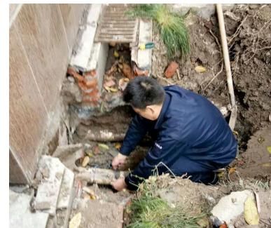
观,事后难以修复还原,要求物业写下保证书,保证施工后恢复原样才同意施工。对该业主提出的要求,李经理都一一答应下来,业主才同意可以打开检修口实施检修。检修口打开后,在上方垂直管道有约50公分长的管路,发现有水泥块堵塞,工程部将堵塞段管路剖开,因是污水总管,里面都是污水、粪便,维修工不仅衣服弄脏,还要忍受着下水道散发的恶臭,对此,维修工人没有退缩,而是出主意、想实招,用手将管道里面堵塞的粪便、水泥块,一点一点地扒出,
